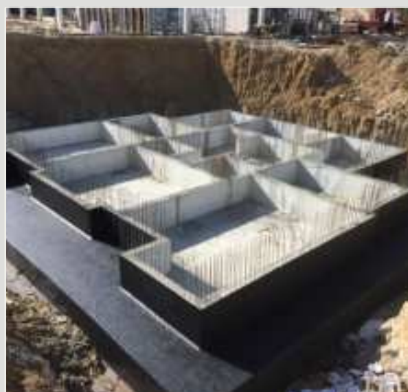
Гидроизоляция фундамента
