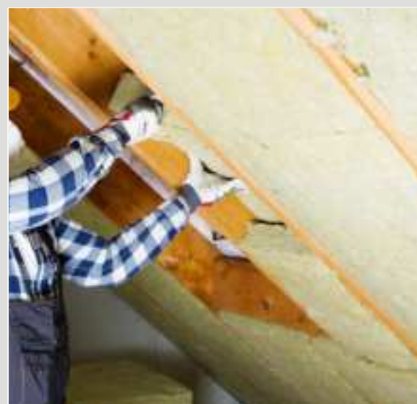
Теплоизоляция крыши
